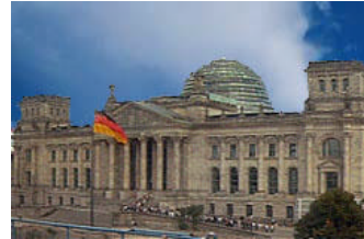
Arbeitsplatz für Oslaner: das Reichstagsgebäude
